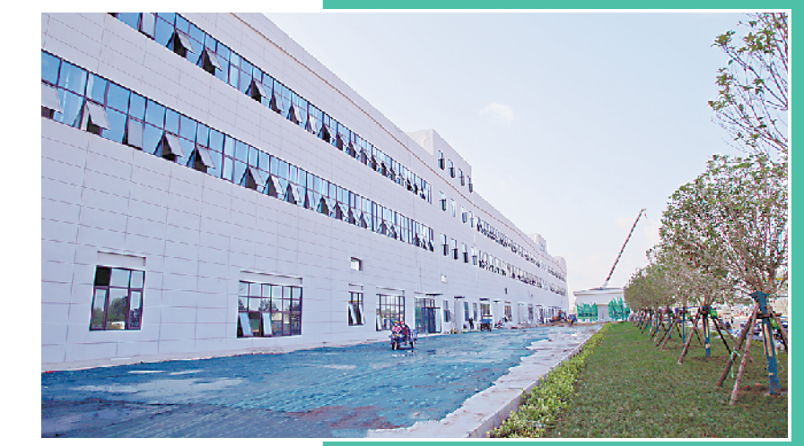
凯旺科技厂房已经竣工,即将投产
